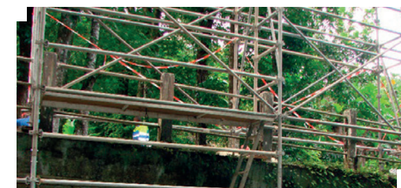
▲ Le nœud CRAB permet la fixation simultanée de 8 éléments : 4 moises et 4 diagonales.
